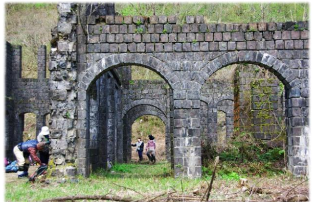
三川地区の持倉鉱山跡地の建物遺構
