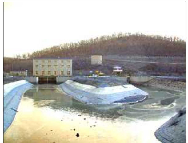
左：発電用トンネル 右：灌漑用トンネル
