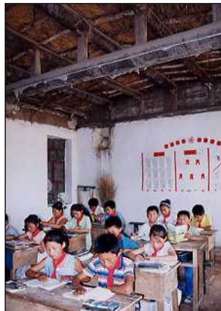
白音諾勒村小学校の教室（雨漏りが激しい）
