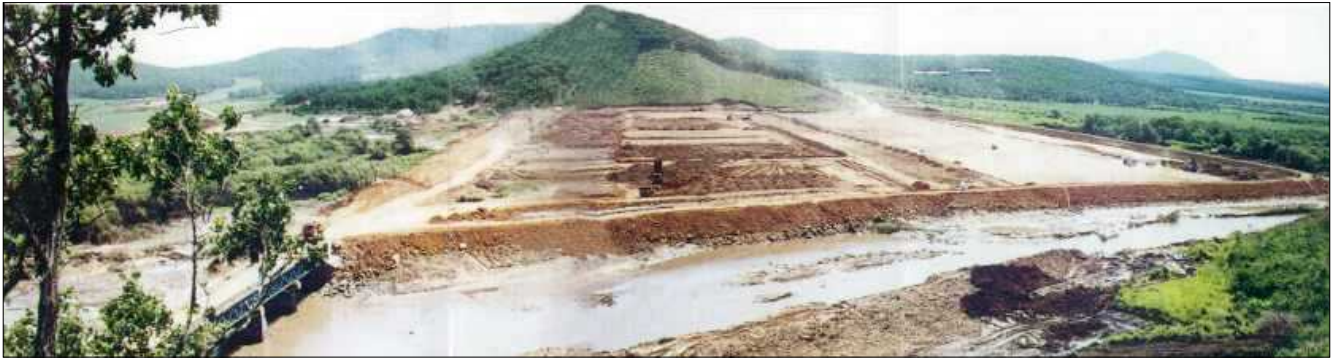
堤体基礎工事
