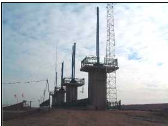
建設中の頭首工
