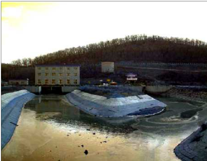
左：発電用トンネル 右：灌漑用トンネル
