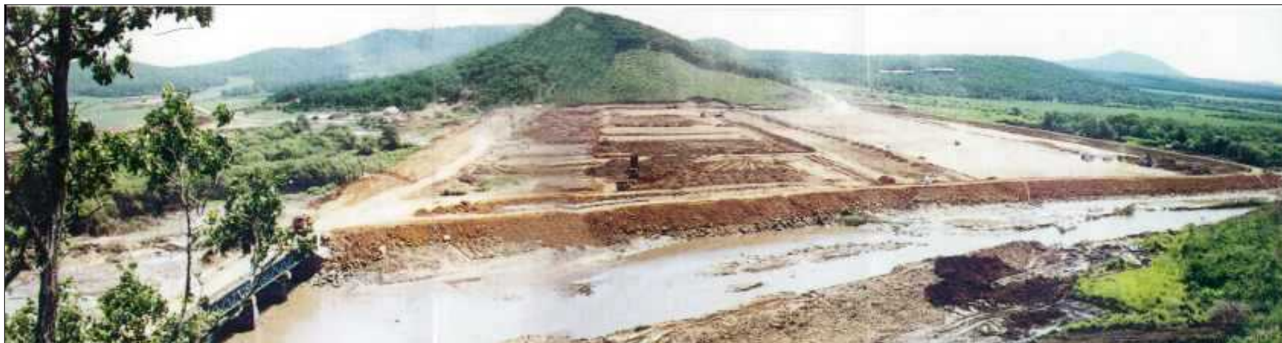
写真：堤体基礎工事
