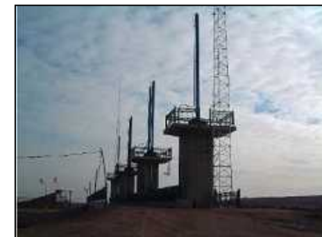
建設された頭首工
