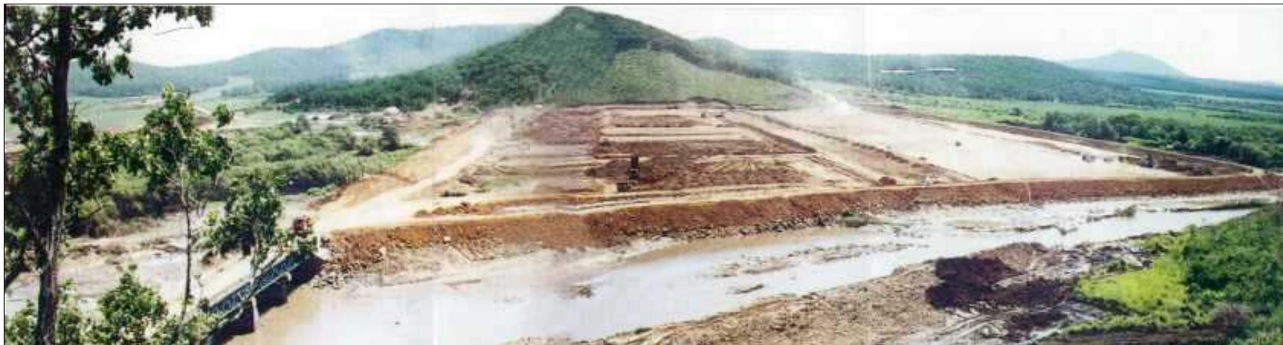
写真：堤体基礎工事
