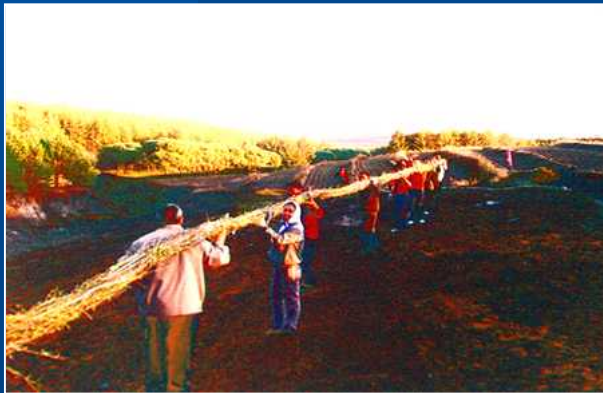
浸蝕等抑止工事
