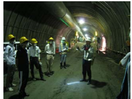
八箇峠トンネル内部の見学の様子
